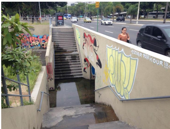
Travessia alagada de esgoto na altura do Edifício Argentina, 2015. Foto: Igor Marques,
