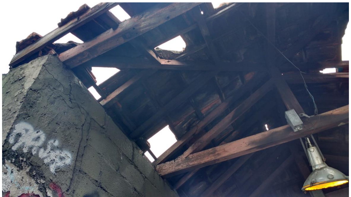
Cobertura da entrada da Rua Amaro Cavalcanti. Foto: acervo pessoal.
