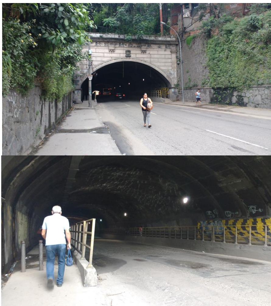
Passagem no Túnel João Ricardo. Pedestres preferem utilizar o túnel apenas durante o dia e evitam ao máximo após às 18h e aos finais de semana. Foto: acervo pessoal.
