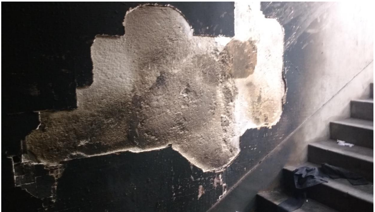
(1) Aviso sobre a conservação da passagem: "o túnel também é seu, conserve-o sempre limpo". (2) Patologias. Foto: acervo pessoal.
